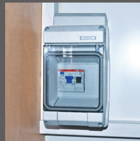
Verteilerkasten mit FI und Sicherung (16 Ampere)
